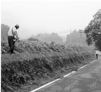
道路法面の草刈り
