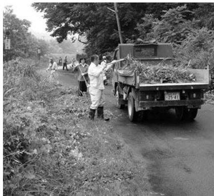
路肩の草刈り
