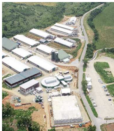
ながめやまバイオガス発電所全景
