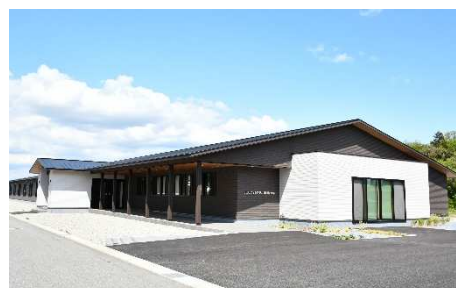
電動モビリティシステム専門職大学外観
