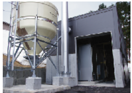
完成したペレットボイラー（庁舎）
