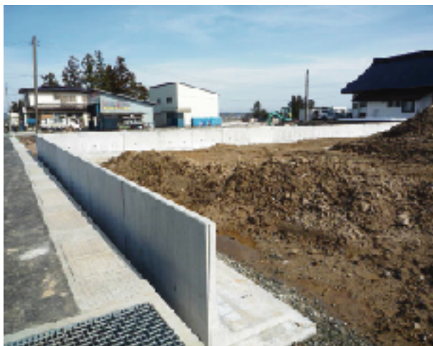
造成中の(仮称)中ノ目南団地(萩生)
