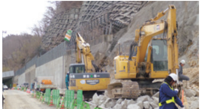
工事が進むダム道路
