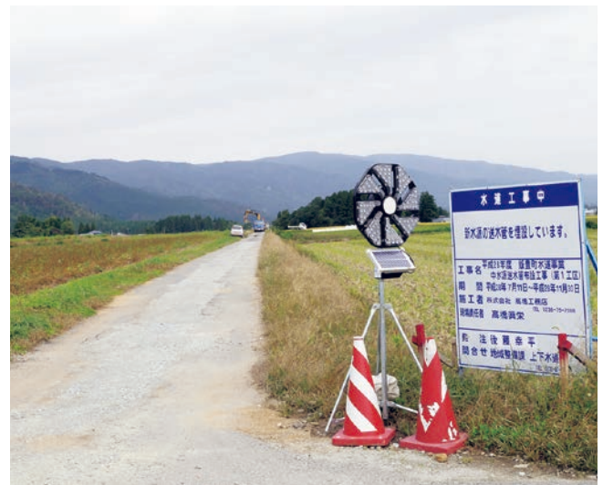
水道事業中水源送水管布設工事現場 (第一工区)
