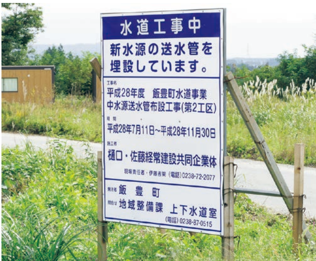
水道事業中水源送水管布設工事現場 (第二工区)
