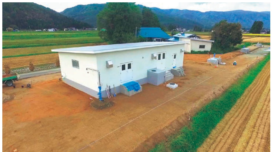
中水源浄水場
