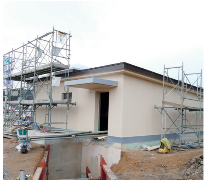
建設中の小水力発電（小白川）
