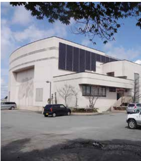
「あ～す」に設置された太陽光パネル
