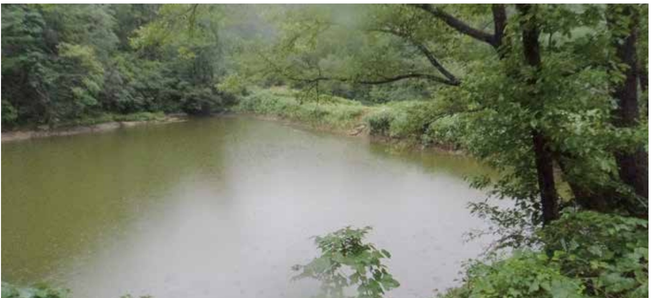
改修が必要な黒沢地内平田沼 へたざわ
