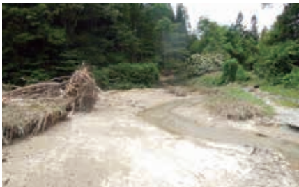
林道の脇の沢も土砂で埋まる
