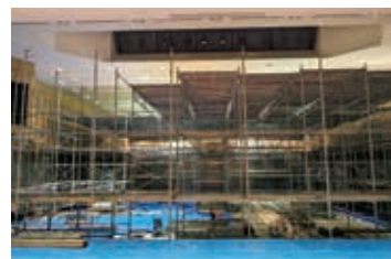
改装工事中の 町民総合センター「あ～す」
