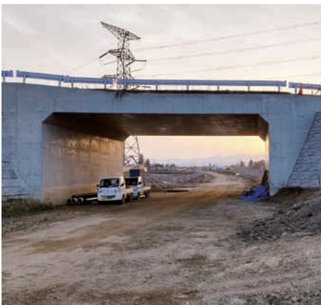
工事が進む梨郷道路
