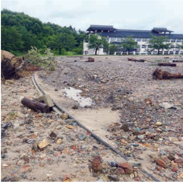
豪雨で土砂が流入した中学校グラウンド
