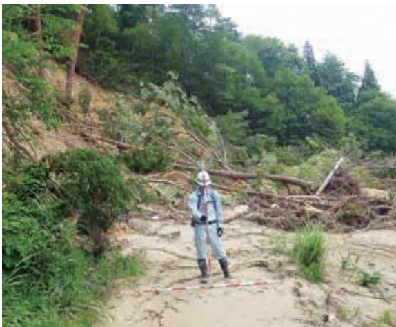
被災した林道の復旧は順次着手
