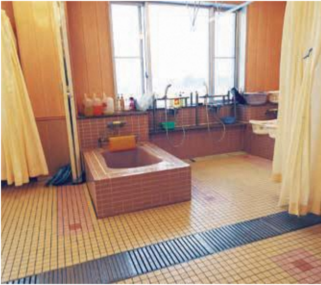
本年度は浴室を利用しやすくするための改修工事が予定されている
